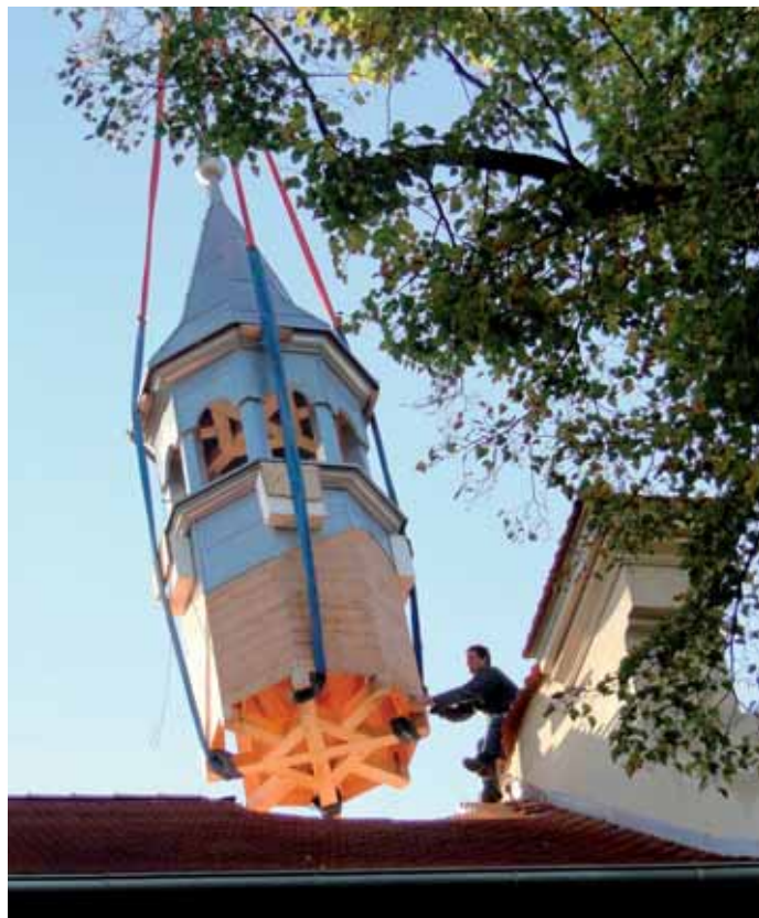
Obnova kostelíku pokračovala letos na podzim instalací věžičky
