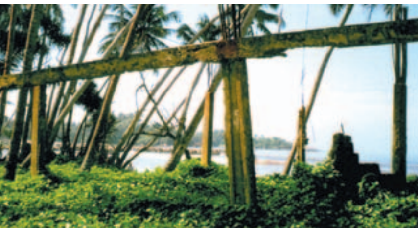
Betonový skelet domu u Kasgody je jediné, co tsunami nechala. Foto Pavel Šebesta
